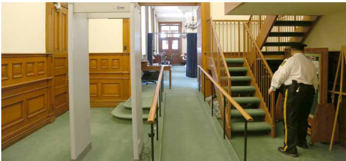
Rampe installée dans le hall ouest.
