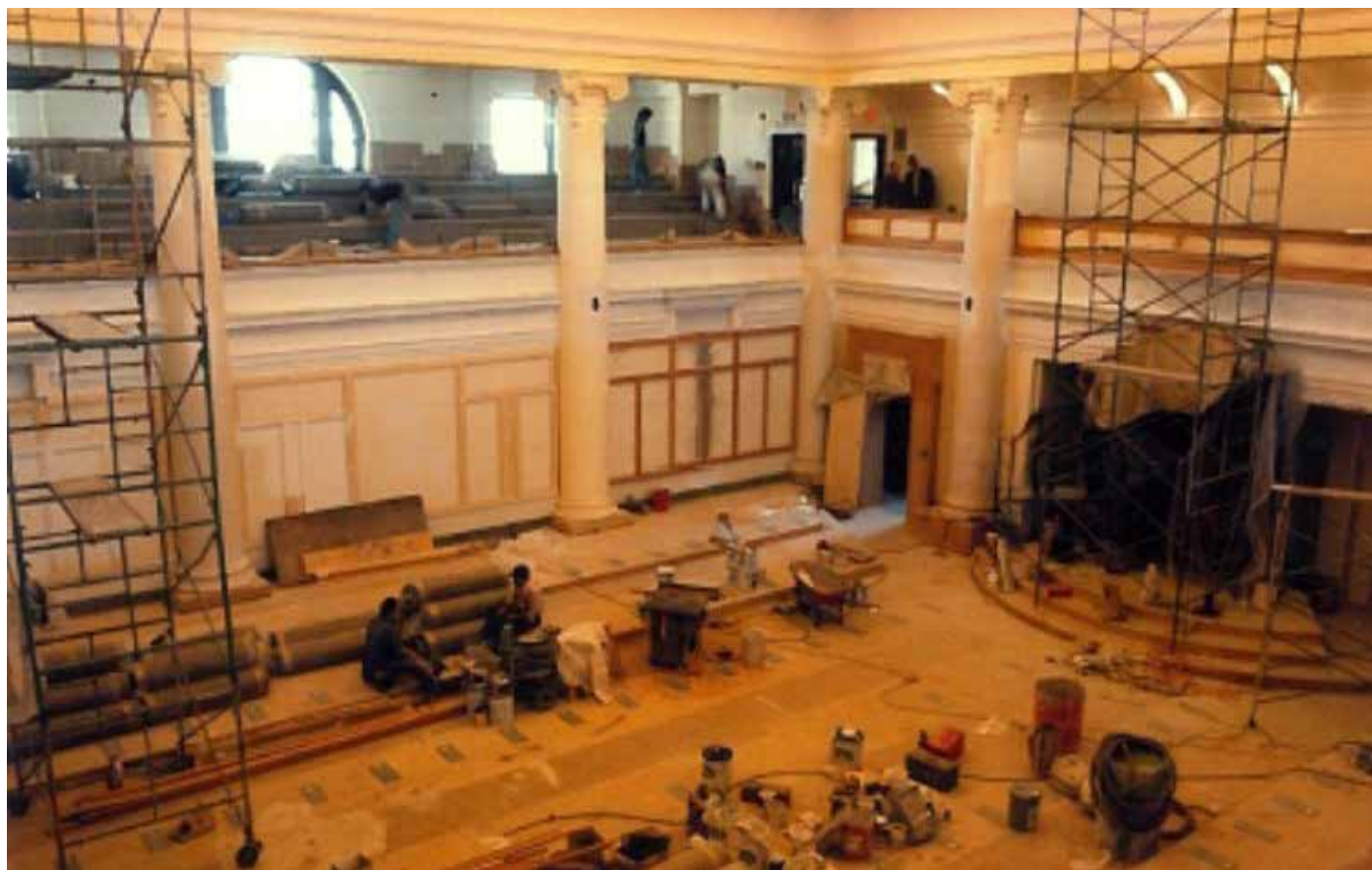
D'importants travaux de rénovation de la Chambre ont été réalisés en 1987, 19 janvier 1987.
