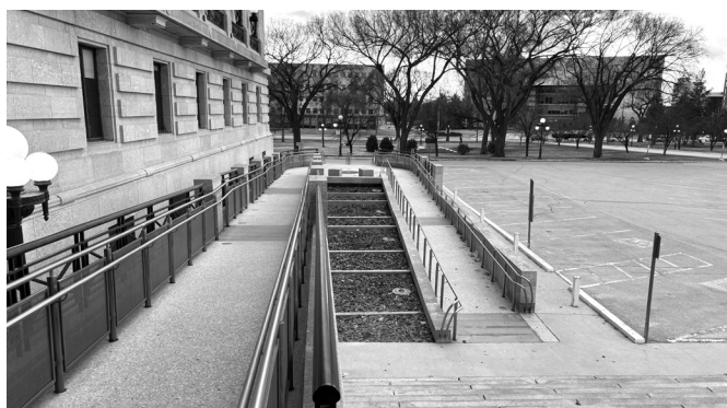
Rampe d'accès extérieure pour fauteuils roulants de l'Assemblée.
